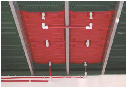
Abb. 12: Verbindung der Thermo W mit dem Stecksystem
