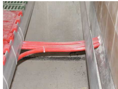
Abb. 13: Verlegung in den Kanal
